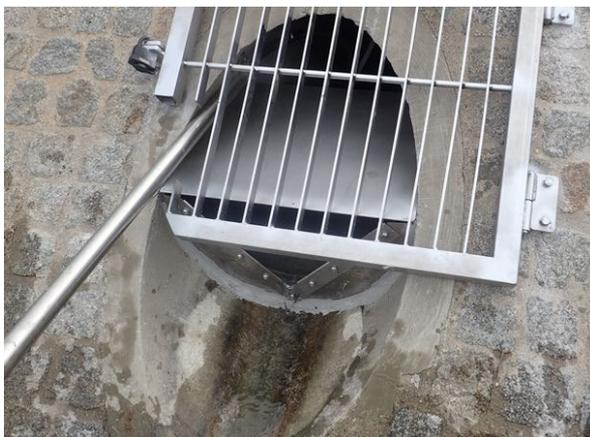
Messblende DN600 mit Drucksonderohr
